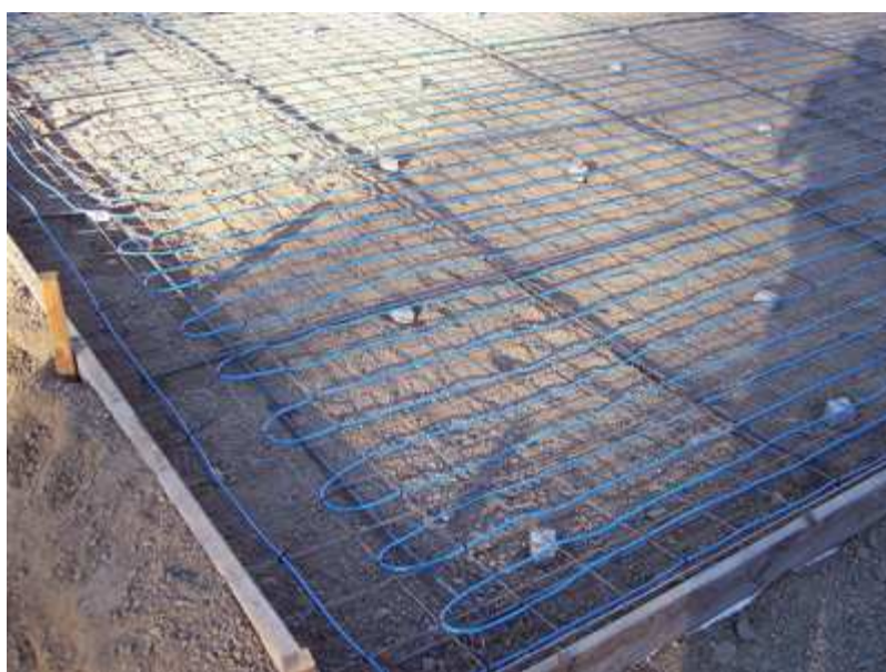
Рисунок 2. Пример укладки нагревательного провода до заливки бетона
